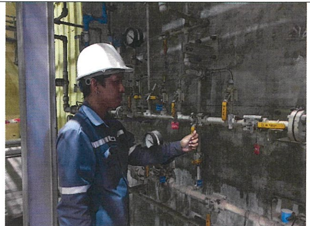
เปิด By-pass เพื่อควบคุม pressure ใน Generator ให้ได้ 3.2 bar
