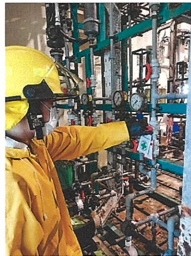
ชุดปฏิบัติการฯ ทำการ Stop NaOCl Pump และปิด Discharge Valve พร้อมแขวน Tag
