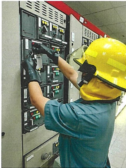
ชุดปฏิบัติการทำการ Rack Out Breaker พร้อมแขวน Tag
